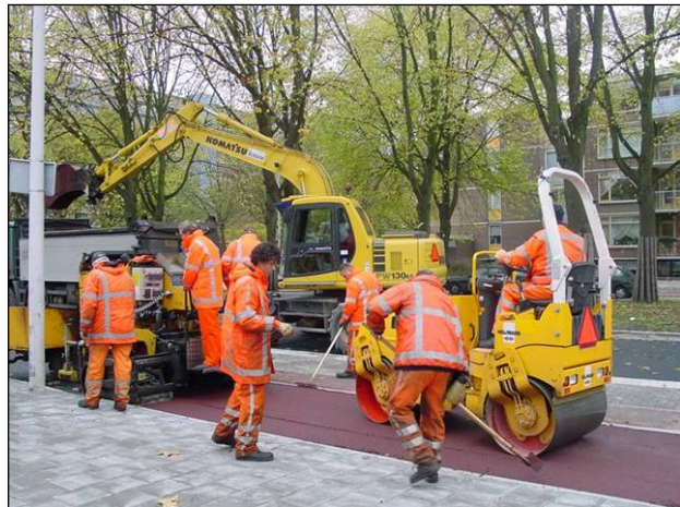
Aanleg fietspaden Volendamlaan
